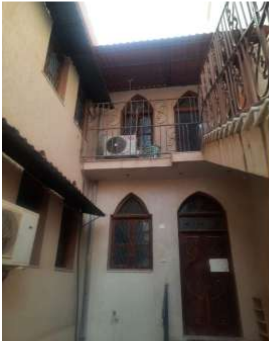
شكل (13) ، (14) سوء اختيار شكل ومواد التشطيب والاضافات العشوائية وسوء الإضاءة
